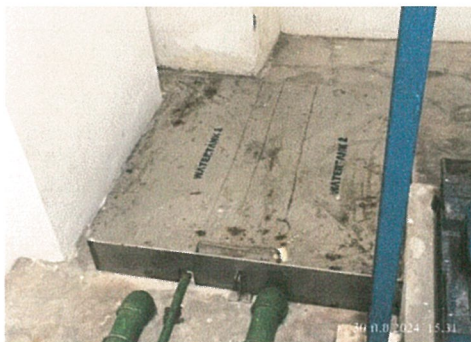
รูปภาพที่ 2.22 ถังเก็บน้ำสำรอง
