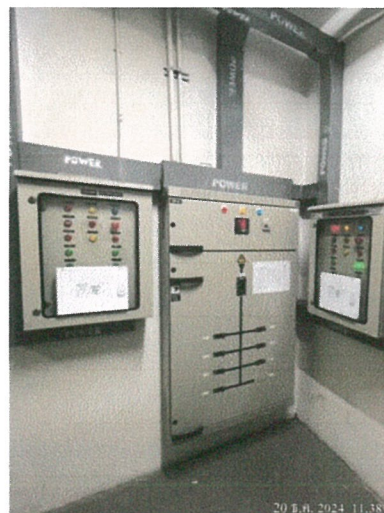
รูปภาพที่ 2.27 ตู้ควบคุมระบบบำบัดน้ำเสีย
